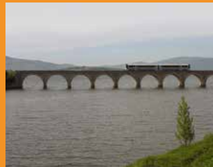
Puente del ferrocarril. Arija
